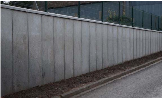
Photo d'un mur de soutènement sur voirie.
