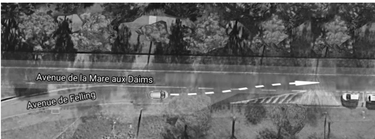
Figure 11 : vue aérienne de la voie d'insertion
